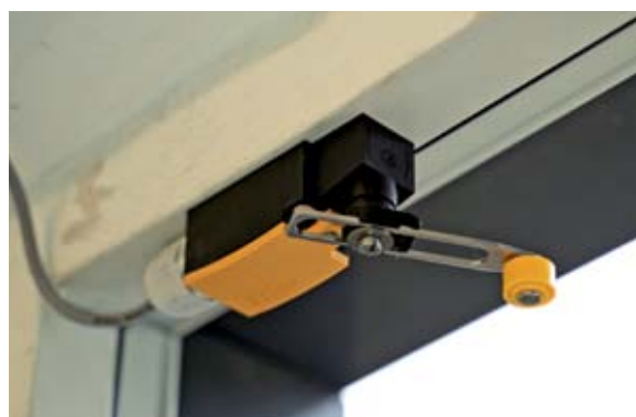
Niepewne styki drzwiowe lub krańcówki rolkowe, których montaż jest kosztowny, nie były brane pod uwagę przy modernizacji systemu zabezpieczenia szaf sterowniczych
