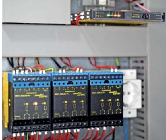
Prosta modernizacja szaf sterowniczych: Niskie koszty instalacji i uruchomienia IM12-CCM przekonali specjalistów e-netz Süd Hessen AG
