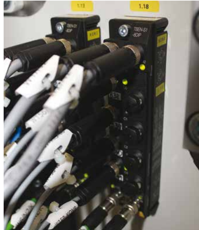
Niewielkie rozmiary kompaktowych modułów I/O serii TBEN-S pozwalają na ich instalację w praktycznie dowolnym miejscu
